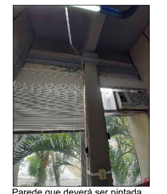
Parede que deverá ser pintada
