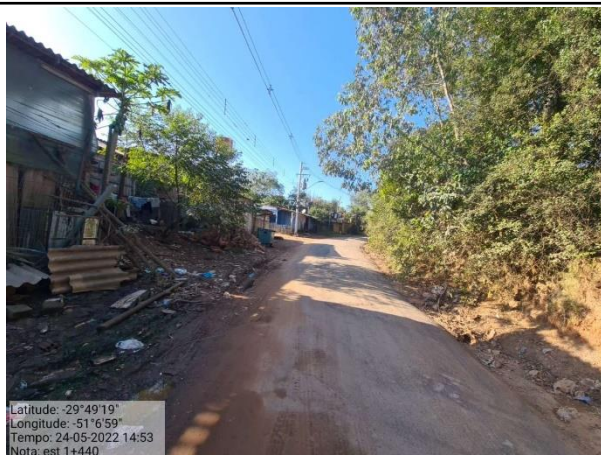
Foto 3: Vista geral do trecho - Estaca 1+440m
