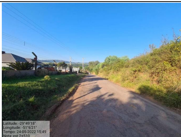
Foto 12: Vista geral do trecho - Estaca 2+510m
