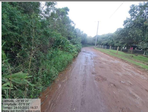
Foto 21: Vista geral do trecho - Estaca 3+620m
