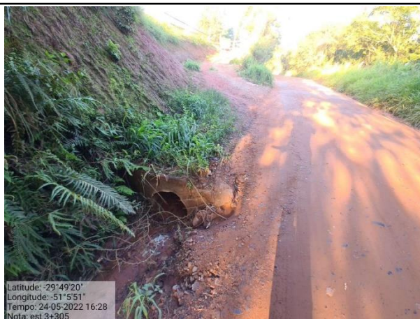
Foto 18: Vista geral do trecho - Estaca 3+305m
