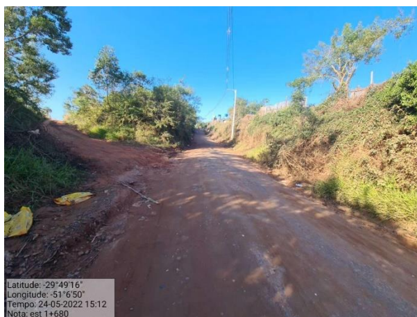
Foto 5: Vista geral do trecho - Estaca 1+680m
