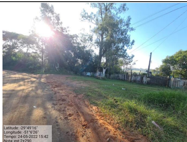
Foto 9: Vista geral do trecho - Estaca 2+290m
