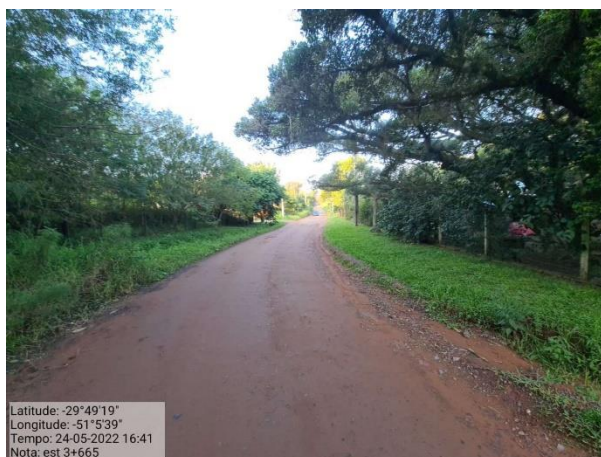
Foto 23: Vista geral do trecho - Estaca 3+665m
