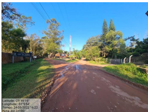
Foto 27: Vista geral do trecho - Estaca 3+180m
