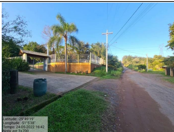
Foto 24: Vista geral do trecho - Estaca 3+700m
