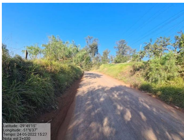
Foto 8: Vista geral do trecho - Estaca 0+030m
