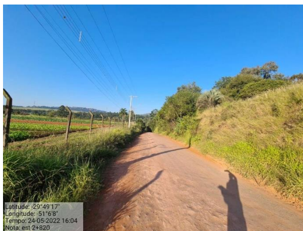
Foto 14: Vista geral do trecho - Estaca 2+820m
