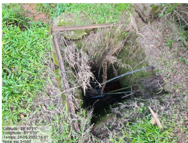
Foto 22: Drenagem existente - Estaca 3+660m
