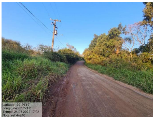
Foto 26: Vista geral do trecho - Estaca 4+240m
