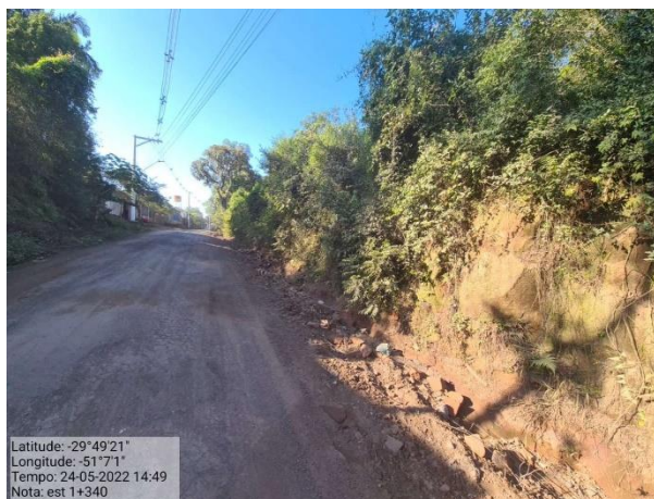
Foto 2: Vista geral do trecho - Estaca 1+340m
