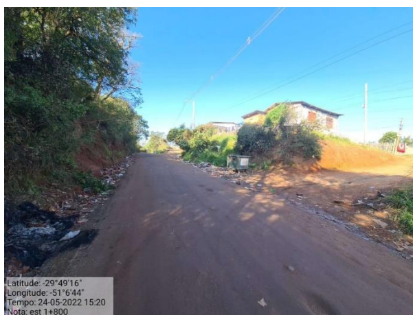
Foto 7: Vista geral do trecho - Estaca 1+800m
