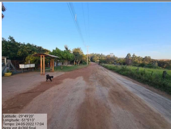
Foto 27: Final do trecho - Estaca 4+360m
