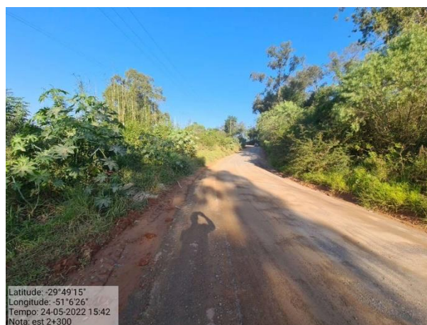
Foto 10: Vista geral do trecho - Estaca 2+300m
