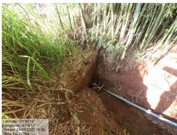
Foto 13: Drenagem existente - Estaca 2+760m
