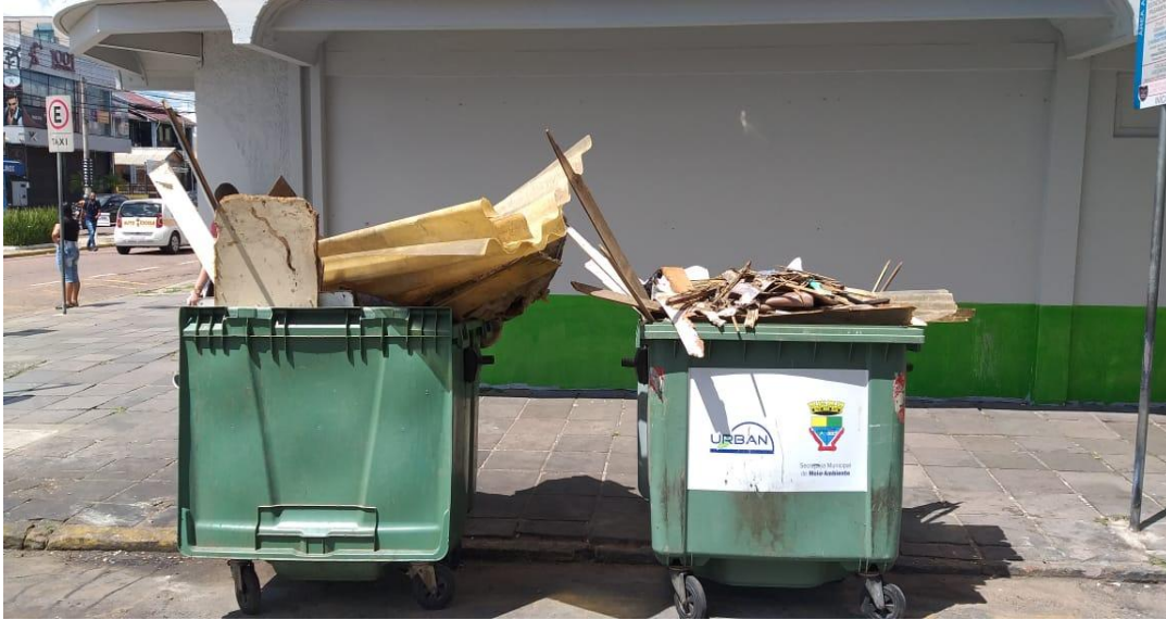
Com materias de demolição de obra civil
