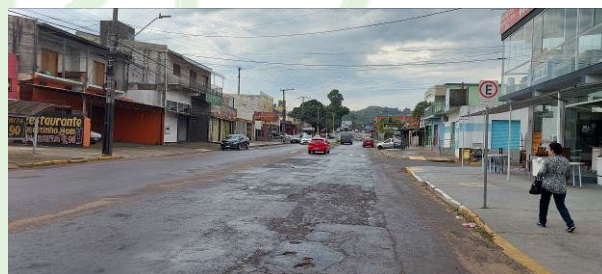
Para leste entre ruas E.N.Vargas e O.Cunha
