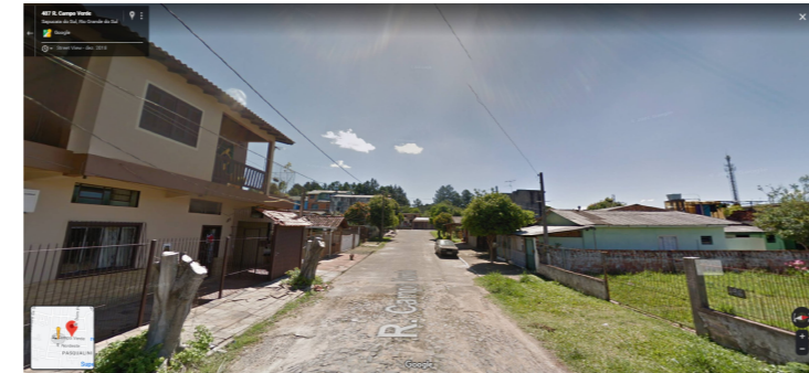
RUA CAMPO VERDE, ATÉ O PONTO EM QUE O PAVIMENTO COM PEDRA IRREGULAR SE TORNA CALÇAMENTO COM BLOCOS DE CONCRETO
