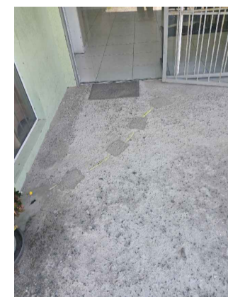
FOTO 05 REFAZER PISO EM CONCRETO - ENTRADA
