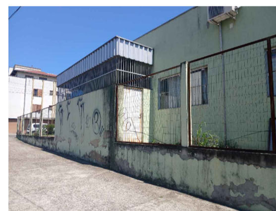
FOTO 01 REBOCO E PINTURA DA MURETA E PAREDES EXTERNAS
