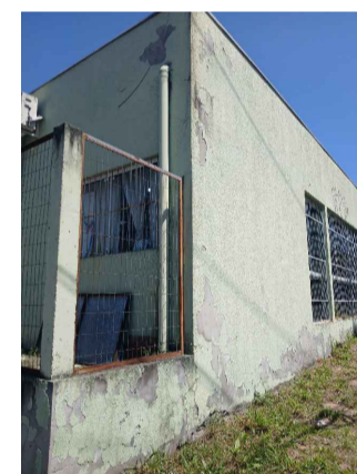
FOTO 02: REBOCO E PINTURA DA MURETA E PAREDES EXTERNAS
