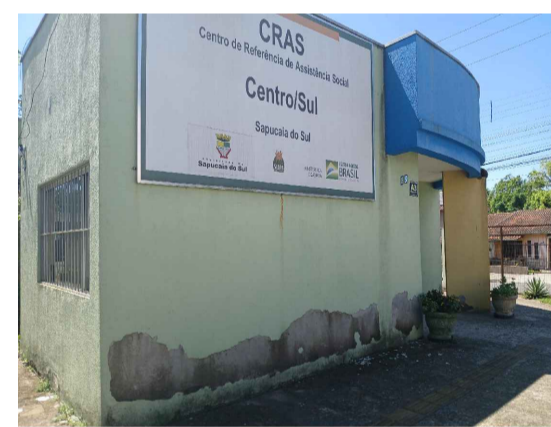
FOTO 03 REBOCO E PINTURA DAS PAREDES EXTERNAS
